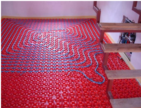
Θέρμανση – Ψύξη – Κλιματισμός
